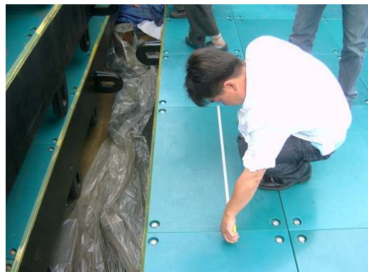
UHMW- PE FOR PANEL 300H X 4500W X 8400L
